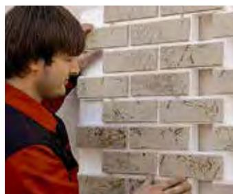
Рис. 24.1. Крепление доборного элемента термопанели
