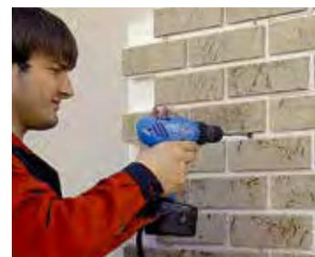
Рис. 24.2. Крепление термопанелей
