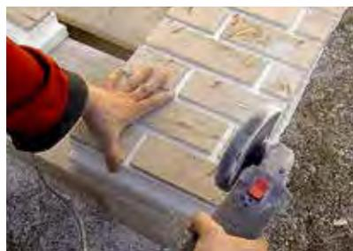
Рис. 25.1. Подрезка термопанели алмазным диском
