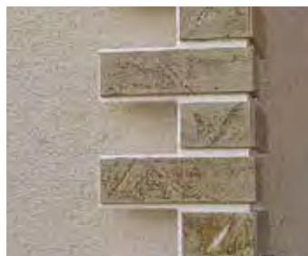
Рис. 23.1. Начало монтажа угла
