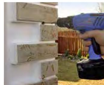
Рис. 23.2. Монтаж самореза в дюбель через втулку
