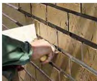
Рис. 29.1. Заполнение швов затиркой между плитками
