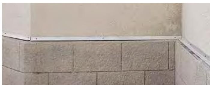
Рис. 21. Вид смонтированного стартового профиля
