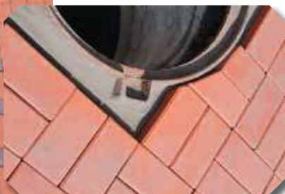
Тротуарный клинкер следует укладывать на подготовленный монтажный слой, соблюдая ширину швов 3-5 мм по рисунку, установленному проектом. Швы расширения должны быть 8-10 мм шириной, а ширина «зеленых» и дренирующих швов определяется при проектировании.
