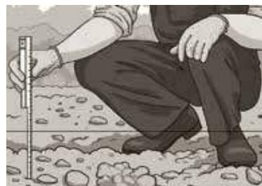
При подготовке несущего слоя осуществляется разметка участка. В ходе разметки участка определяются высоты, углы, направление уклона для дренажа. Для фиксации разметки натягиваются нити.
